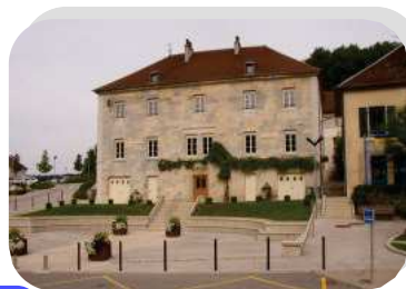
La mairie, au centre du village
